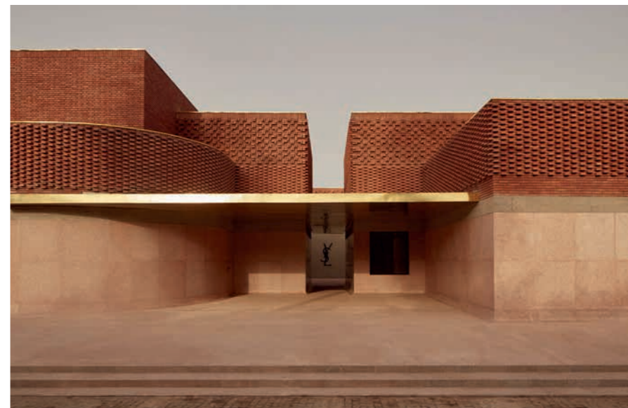
По задумке архитекторов Studio KO, авторов проекта Музея Ива Сен-Лорана, кирпичная кладка имитирует переплетение нитей полотна
